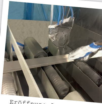
Eröffnung Lackanlage Klosterfelde
